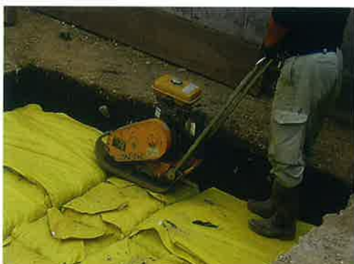
6) プレートランマー等を使用して、各段毎に転圧する。
