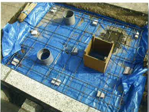
7) D・BOX-K施工後、ブルーシートを敷き、コンクリートがD・BOX-Kに流れ込まないようにする。
