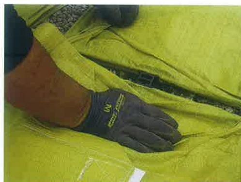
2) D・BOX-Kをロックジョイントを使用して連結する。
