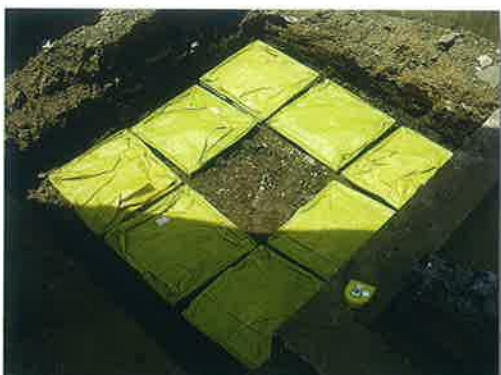
3) 連結したD・BOX-Kを掘削した箇所に敷設する。
