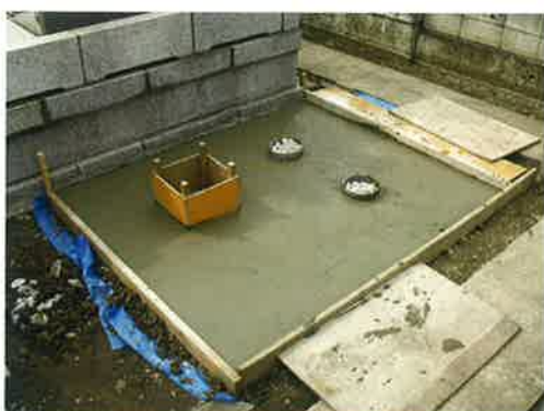
8) 基礎工事終了後、水抜き部分のシートをカットする。その際、D・BOX-Kを傷つけないように気をつける。
